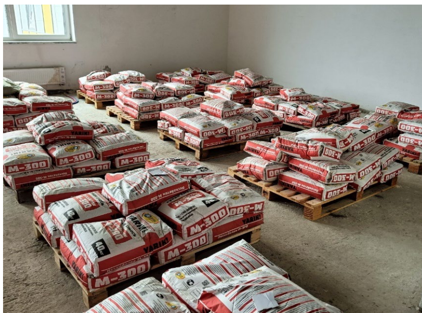
Рис. 4. Размещение грузов на плите перекрытия
